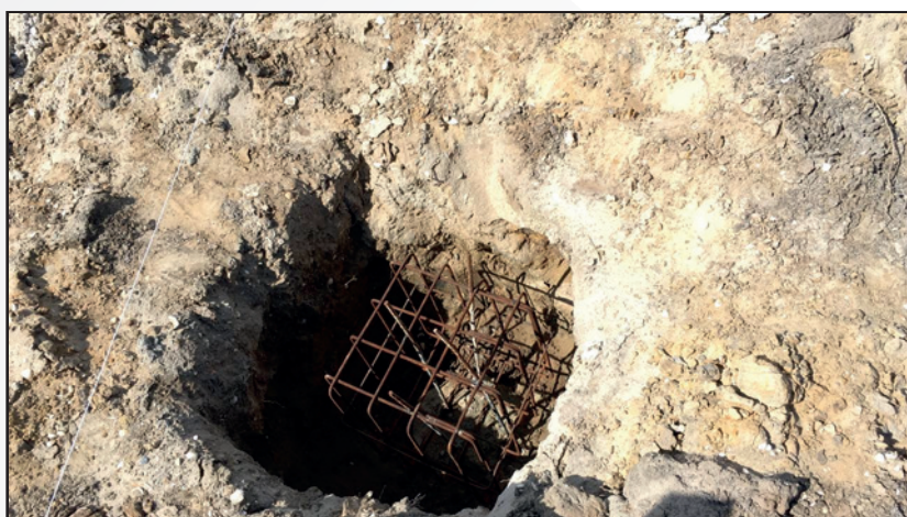
BLOCOS DE CORDAMENTO DAS ESTACAS TIPO STRAUSS.
